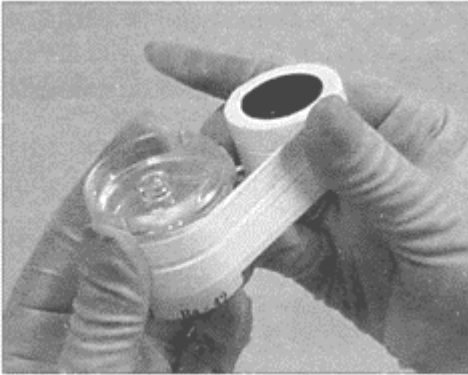
Figura 4a – Vedação com fita tipo teflon
